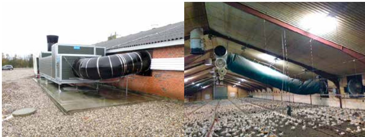
Figur 1. Billede af en Agro Clima Unit varmeveksler placeret udenfor en slagtekyllingestald, samt af fordelingsystemet, der sikrer at den opvarmede luft fordeles ud i staldrummet. Varmevekslere benyttes i stigende omfang i forbindelse med slagtekyllingeproduktion med henblik på at reducere produktionens energiforbrug og ammoniakudledning.
